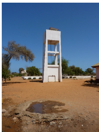
Le château d'eau
